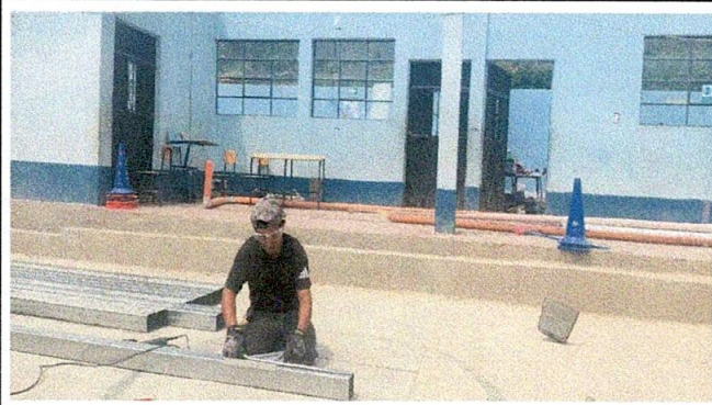
Foto 3: Evidencia fotográfica del especialista en estructuras metálicas
