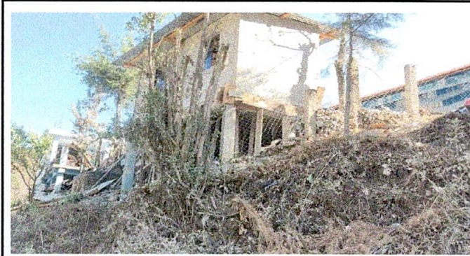
Foto 9: Muros exteriores a remozar del centro educativo
