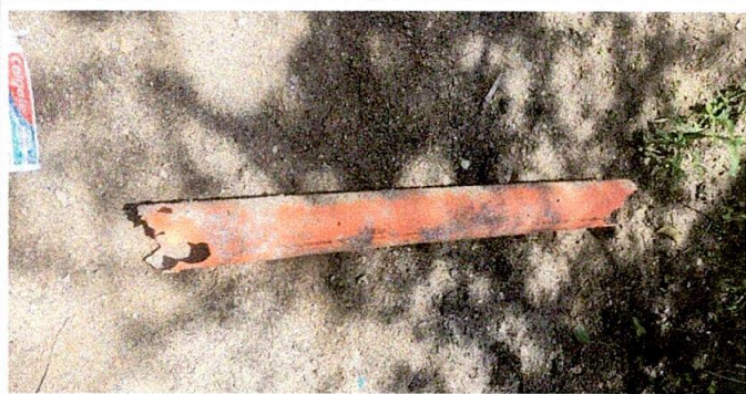
Foto 21: Sustitución de tubos deteriorados con diversas fugas de aguas negras
