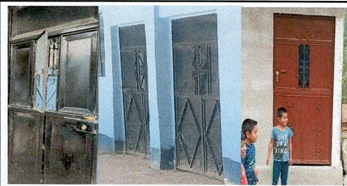
Foto 5: mantenimiento a puertas de metal (lijado, cepilado y aplicación de pintura) en proceso a remozar
