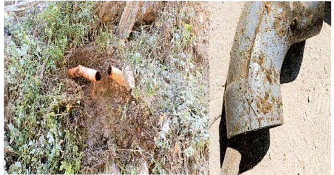
Foto 20: Reparación de tubos de drenaje tapado por desechos y estos impedían el paso de aguas negras
