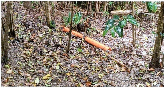
Foto 19: Reparación de todos los tubos de drenaje aguas negras en proceso del centro educativo
