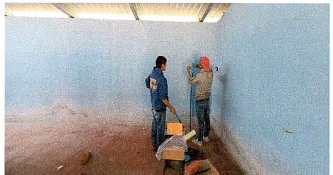
Foto 10: mantenimiento a muros interiores del centro educativo
