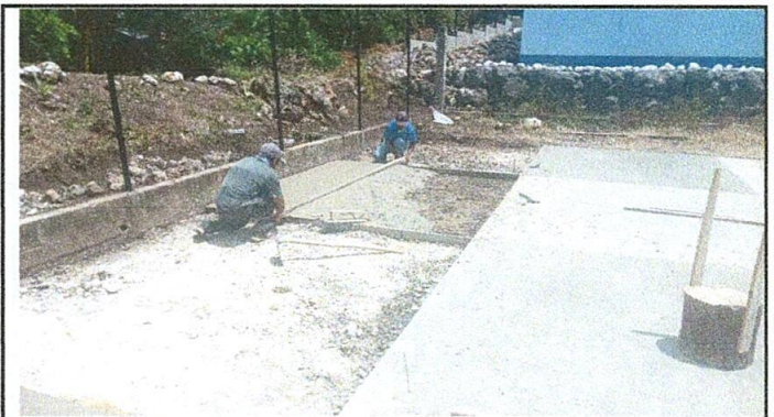
Foto 4: LOSA DE PATIO: reparación de planchas de concreto de patio.
