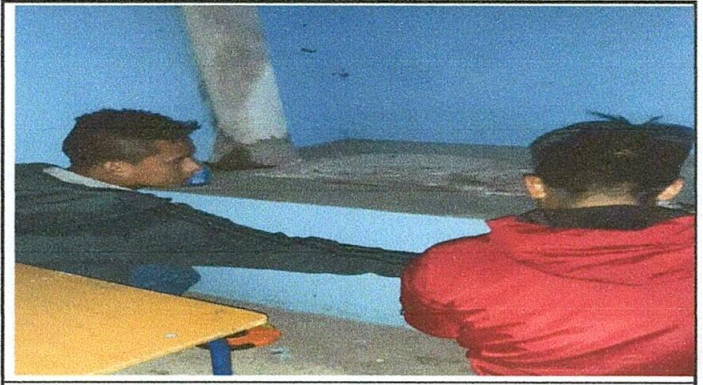
Foto 2: REPARACION DE COCINA: instalación de azulejo en estufa rural.
