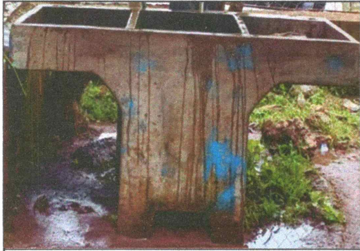
FOTO 9: La pila está deteriorada .
