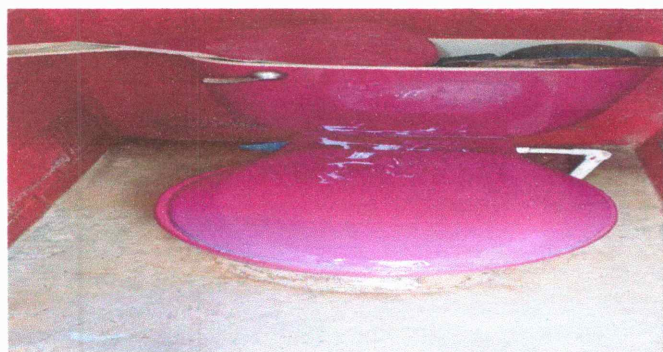
FOTO 5: Sustitución de inodoros
