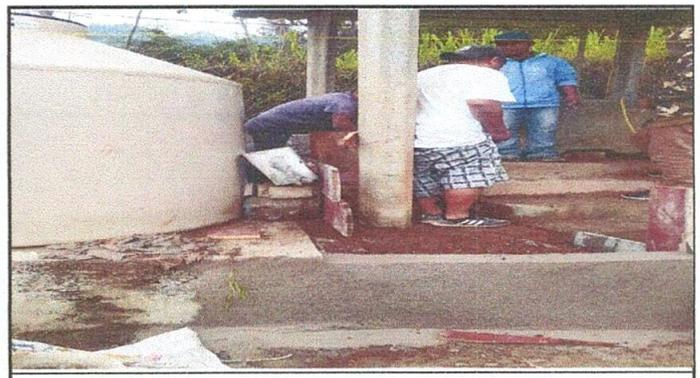
Foto 6: Pila. Colocación de pizo de granito en el depósito de agua y cambio de pila de dos lavaderos
