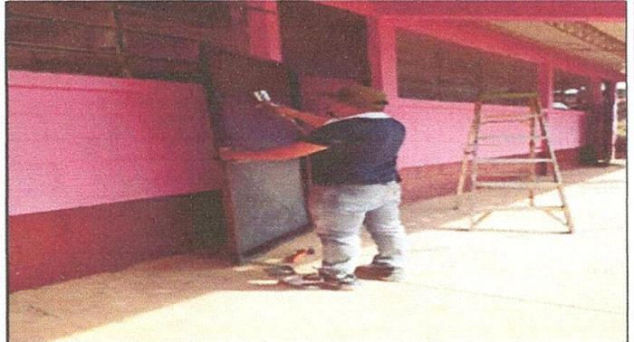
Foto 4: Puerta de las aulas. Mantenimiento de las puertas de metal pintado y cambio de las chapas.
