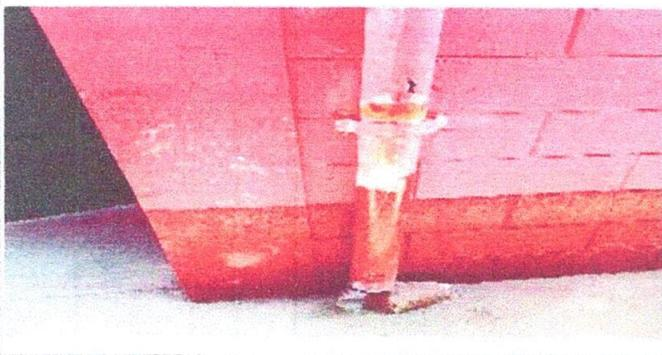
Foto No. 7. Sustitución de canal de PVC y bajada de agua
