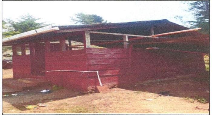
Foto 2: cocina: Sustitución de estufa rural incluye chimenea y plancha de metal , sustitución de madera por lamina troquelada aluzin calibre 26 y sustitución de madera por costanera.
