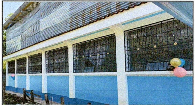
Foto 2: Fabricación e instalación de balcones para ventanas/Fuente: Archivo Propio
