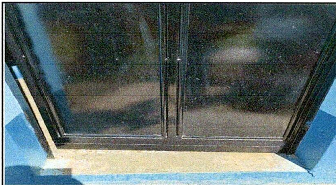
Foto 3: Mantenimiento para puertas/Fuente: Archivo Propio
