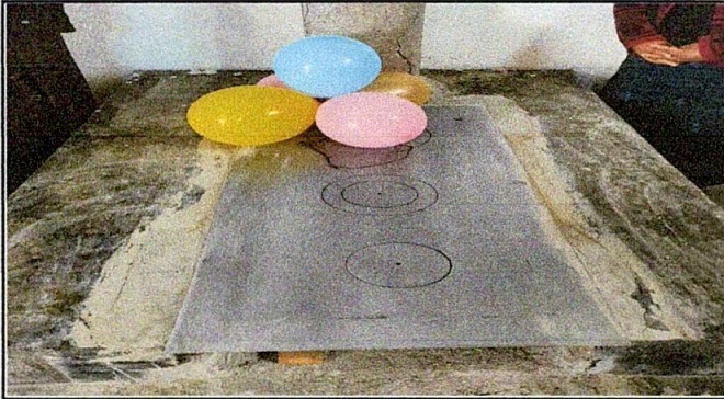
Foto 7: /Sustitución de Plancha/Fuente: Archivo Propio
