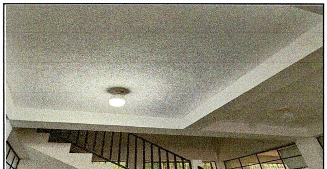
Foto 6: Sustitución de focos ahorradores/Fuente: Archivo propio
