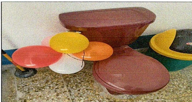
Foto 5: Sustitución de inodoros/Fuente: Archivo Propio
