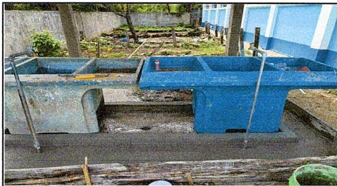
Foto 9: /Sustitución de la pila/Fuente: Archivo Propio
