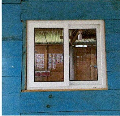
Foto 7: Sustitución de ventana de madera por metal mas vidrio
