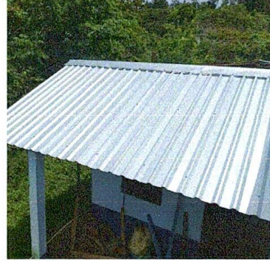
Foto 2: Cubierta de lámina para el modulo de cocina
