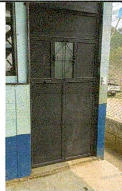
Foto 4: Mantenimiento a estructuta de metal
