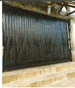
Foto 6: Sustitución de portón de metal
