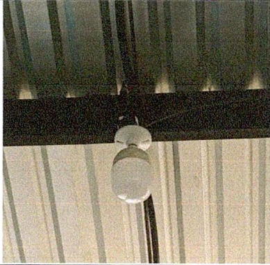
Foto 13: Sustitución de cableado y ducto eléctrico
