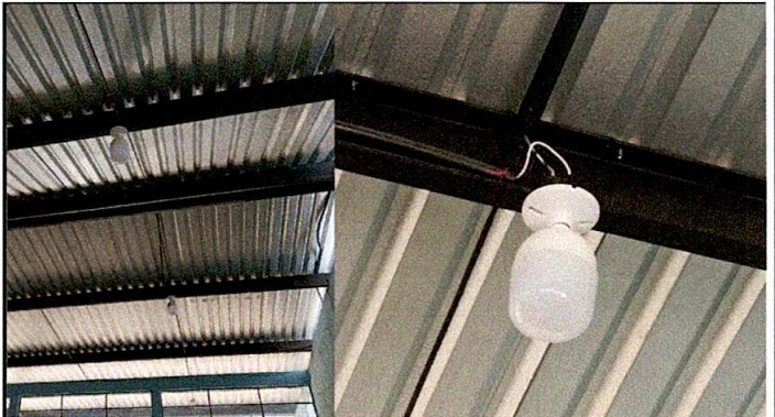
Foto 10: Sustitución de lamparas ahorradores y flaponeras
