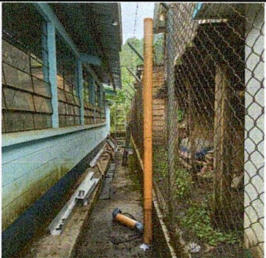
Foto 9: Sustitución de bajada de agua pluvial de tubo por tubo PVC 3"
