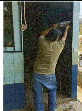
Foto 4: Mantenimiento a estructura de metal
