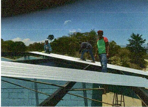
Foto 1: Cubierta de lámina para aulas
