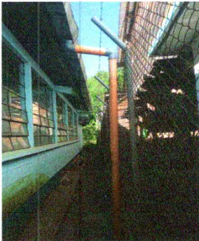
Foto 9: Sustrucción de bajada de agua pluvial de tubo por tubo PVC 3"
