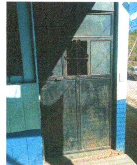
Foto 4: Mantenimiento a estructura de metal
