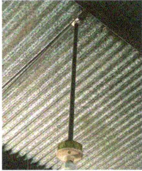
Foto 13: Sustitución de cableado y ducto electrico
