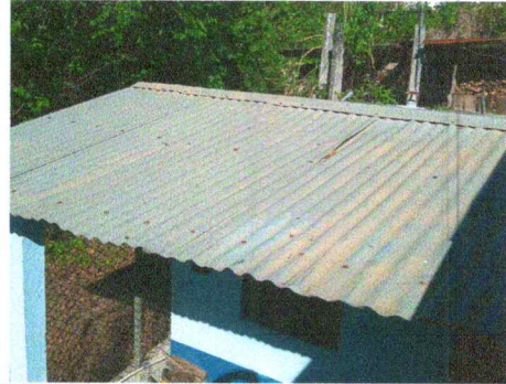
Foto 2: Cubierta de lámina para el modulo de cocina
