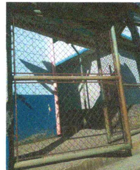
Foto 6: Sustitución de portón de metal
