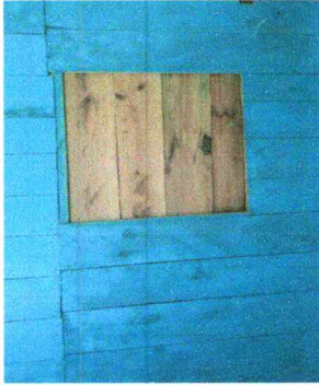
Foto 7: Sustrucción de ventana de madera por metal mas vidrio
