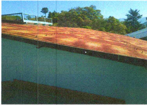
Foto 1: Cubierta de lámina para aulas
