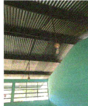
Foto 10: Sustrucción de lamparas ahorradores y flaponeras
