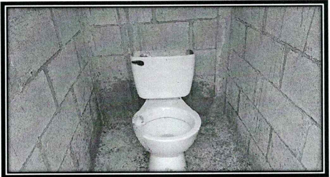
Foto 8: Sustitución de inodoros
