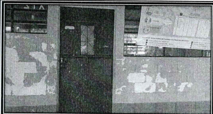
Foto 2: Mantenimiento de puertas de metal de aulas, cocina y dirección del establecimiento educativo
