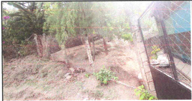
2. Reparación de muro perimetral de block con tubo hg y malla galvanizada
