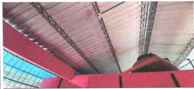
4. Sustitución de estructura de soporte de hierro, por metal
