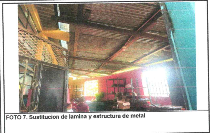
FOTO 8. Sustitución de lamina y estructura de metal
