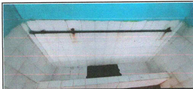
5. Sustitución de mingitorio
