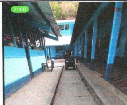
6. Sustitución de canal de metal
