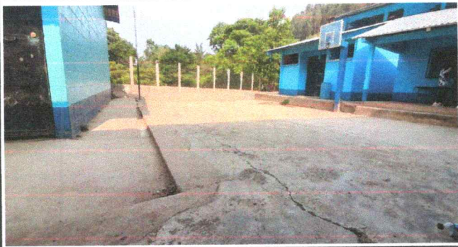
Foto 1: Sustitución de piso de torta de concreto
