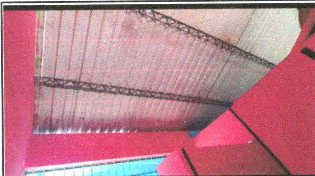
3. Sustitución de lámina, por lámina troquelada calibre 26
