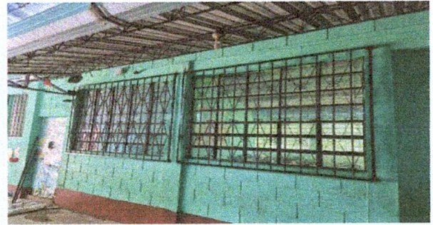
BALCONES DE LAS AULAS YA INSTALADOS.
