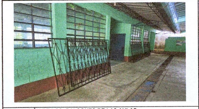
INSTALACIÓN DE LOS BALCONES DE LAS AULAS.
