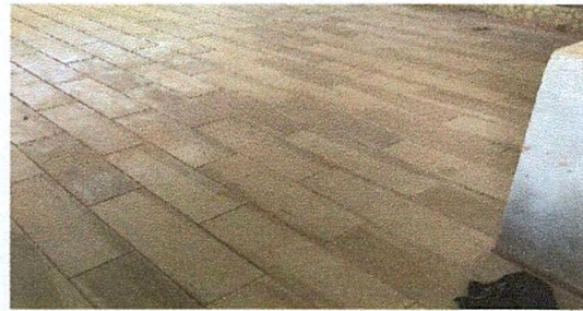
Foto 4: Sustitución de piso de concreto a piso de duelas.
