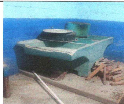
Foto 6: Sustitución de pila de cemento de dos lavaderos
