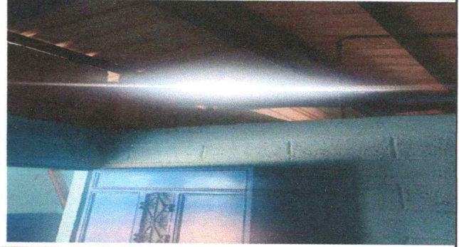
Foto 2: Sustitución de lámina, por lámina troquelada
