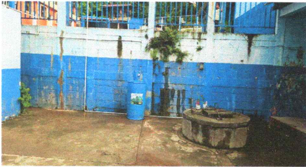
Foto 3: Pintura en muros exteriores e interiores
