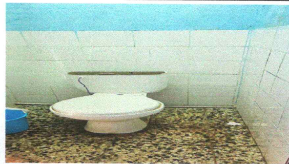
Foto 4: Sustitución de inodoro
