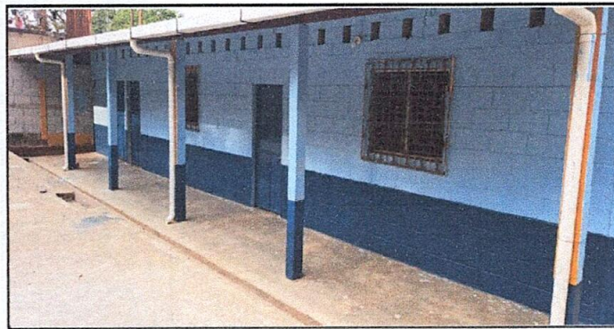
Foto 11: Instalación terminada de 3 puertas de metal en ambiente de dirección y aulas.
