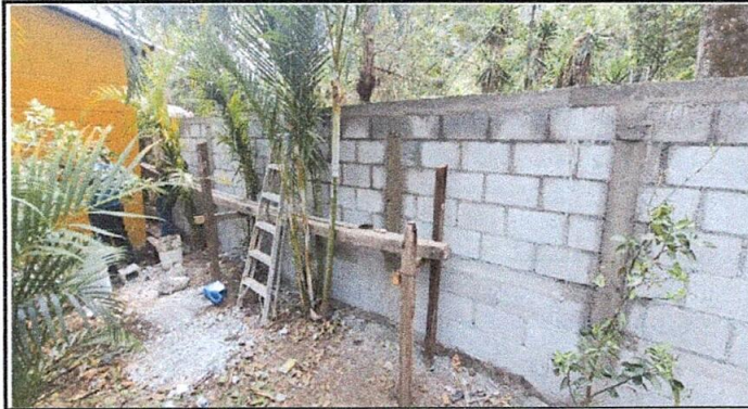
Foto 7: Muro perimetral con material de block, hierro y cemento, reparación de columnas en mal estado. TERMINADO.
