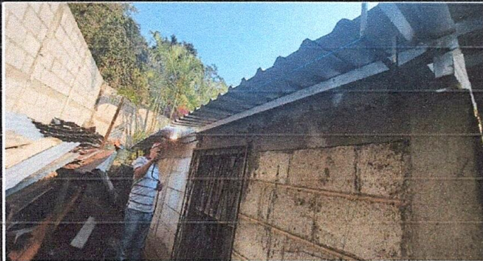
Foto 13: Instalación de soportes de metal para canal de aguas pluviales en ambiente de cocina parte trasera.
