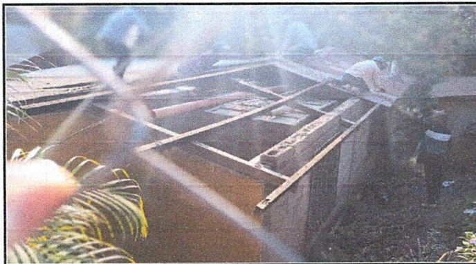
Foto 3: Desmontaje de techo de escenario y cocina y bodega
