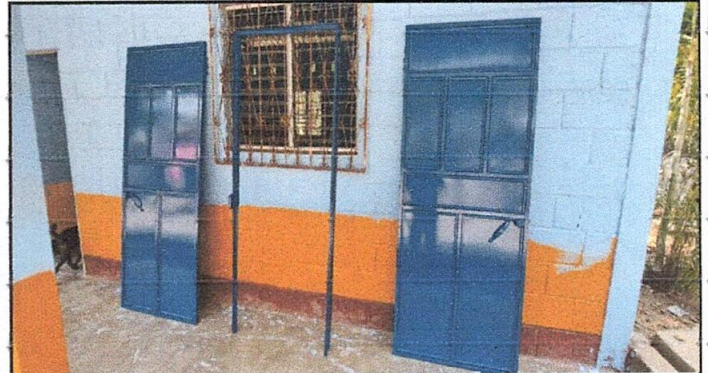
Foto 16: Instalación de puertas nuevas en todos los ambientes.
