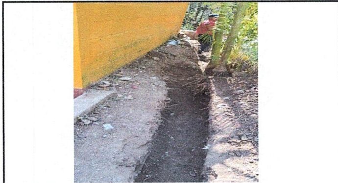
Foto 9: Zangado para instalación de tubos de drenaje para aguas pluviales
