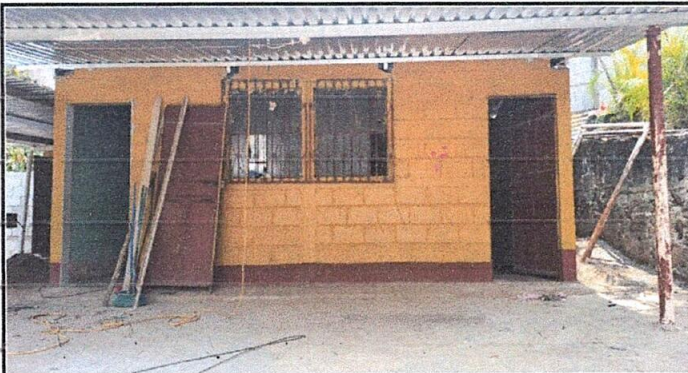
Foto 15: Desinstalación de puertas en cocina y bodega.
