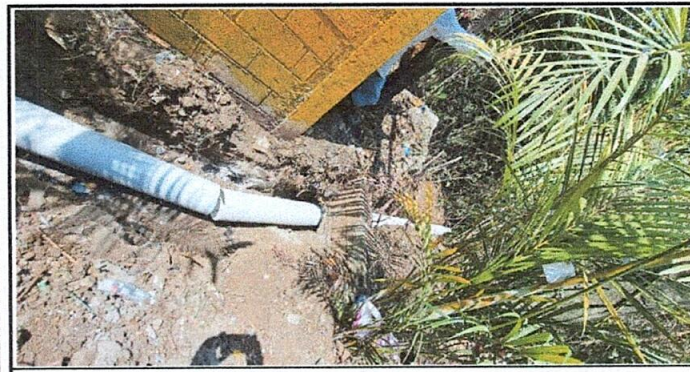
Foto 11: Instalación de tubos de 8 pulgadas para drenaje de aguas pluviales.
