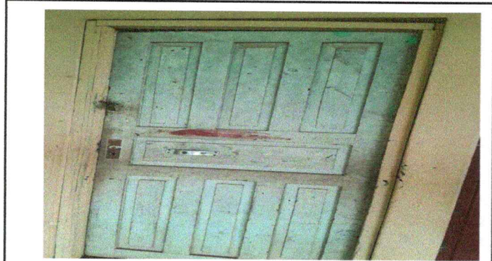
Foto7: Sustrucción de puertas.
