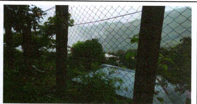
Foto 22: Sustrucción de malla perimetral
