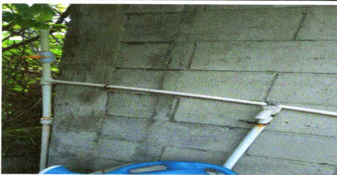
Foto 23: Sustrucción de tubos PVC
