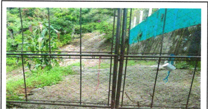
Foto 9: Sustrucción de portón.
