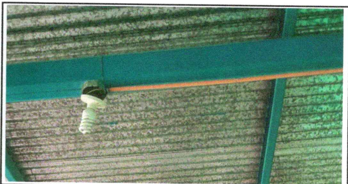
Foto 6: Reparación de sistema eléctrico
