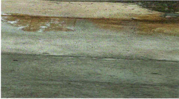
Foto13: Sustitución de piso granito
