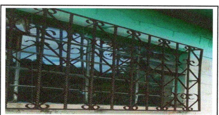
Foto 11: sustitución de balcones.
