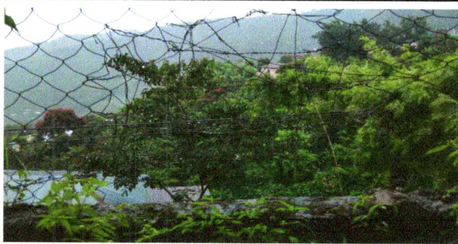
Foto 21: Sustrucción de malla
