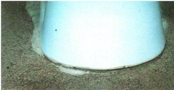
Foto 17: Sustitución de inodoro
