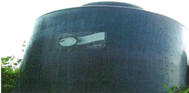
Foto 15: Sustitución de deposito de agua
