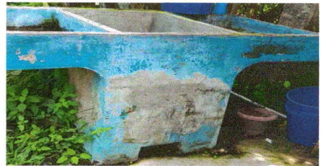
Foto 18: Sustitución de pila de cemento
