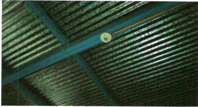
Foto 19: Sustrucción de plafoneras
