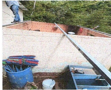
Foto 4: sustitución de estructura de madera por metal (área de cocina)
