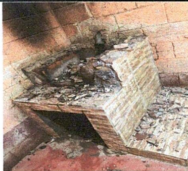
Foto 5: instalación de estufa rural completa, chimea y plancha de metal
