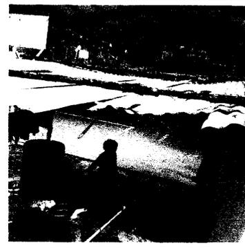
Foto 4: sustitución de estructura de madera por metal (área de cocina)
