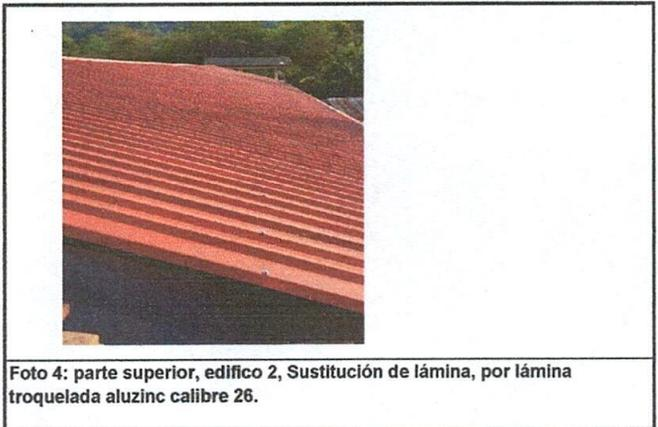
Foto 4: parte superior, edificio 2, Sustitución de lámina, por lámina troquelada aluzinc calibre 26.
