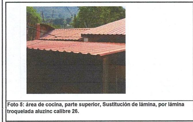
Foto 5: área de cocina, parte superior, Sustitución de lámina, por lámina troquelada aluzinc calibre 26.
