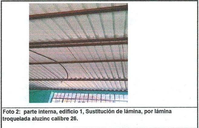
Foto 2: parte interna, edificio 1, Sustitución de lámina, por lámina troquelada aluzinc calibre 26.
