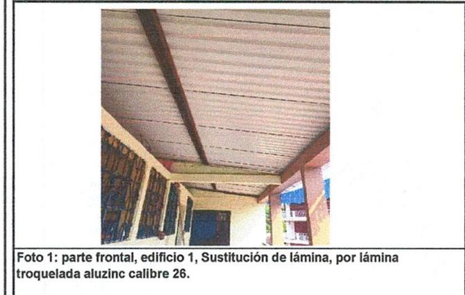
Foto 1: parte frontal, edificio 1, Sustitución de lámina, por lámina troquelada aluzinc calibre 26.
