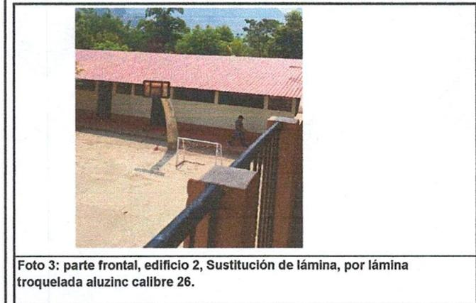
Foto 3: parte frontal, edificio 2, Sustitución de lámina, por lámina troquelada aluzinc calibre 26.
