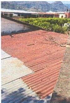
Foto 5: área de cocina, parte superior, Sustitución de lámina, por lámina troquelada aluzinc calibre 26.
