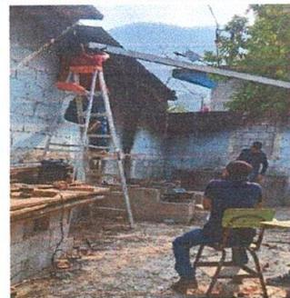
Foto 5: área de cocina, parte superior, Sustitución de lámina, por lámina troquelada aluzinc calibre 26.
