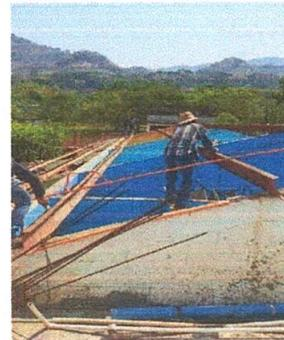
Foto 4: parte superior, edificio 2, Sustitución de lámina, por lámina troquelada aluzinc calibre 26.
