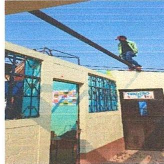
Foto 2: parte interna, edificio 1, Sustitución de lámina, por lámina troquelada aluzinc calibre 26.
