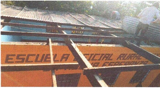
SE A ELIMINADO LA LAMINA
