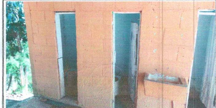
Foto 5: Los baños en mal estado, se necesita reemplazar.
