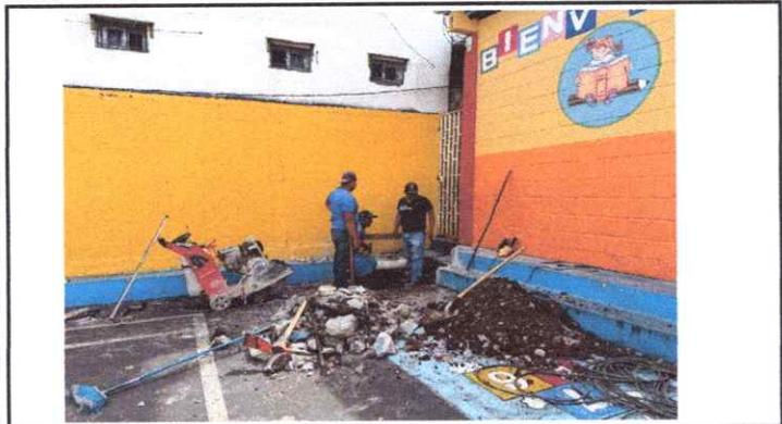
Foto1: Reparación de banquetas de concreto
