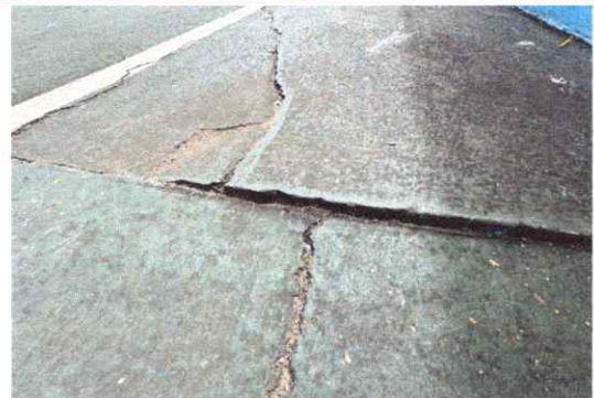
Foto 6: Reparación de planchas de concreto de patio
