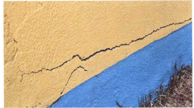
Foto 2: Sello de grietas y fisuras
