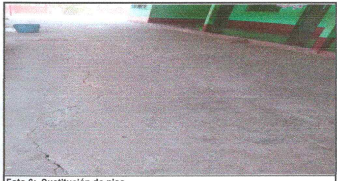
Foto 6: Sustrucción de piso
