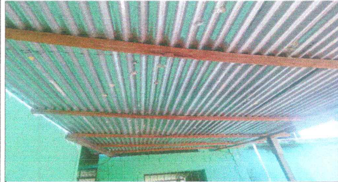
Foto 1: Sustrucción de estructura de techo
