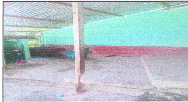
Foto 3: Sustrucción de estructura de soporte de techo
