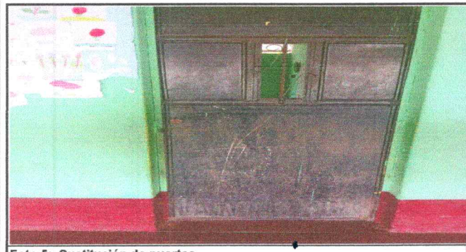
Foto 5: Sustrucción de puertas
