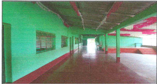
Foto 2: Pintura en muros exteriores e interiores
