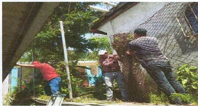
SUSTITUCIÓN DE MALLA
