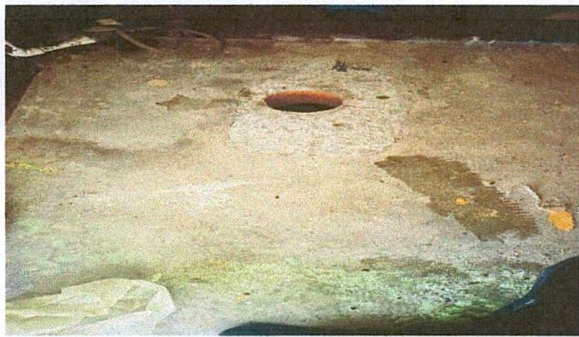
MEJORAMIENTO DE SISTERNA
