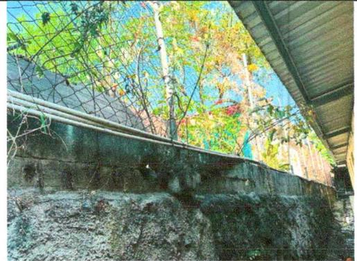
Foto 2: Reparación de tubo hg y malla galvanizada
