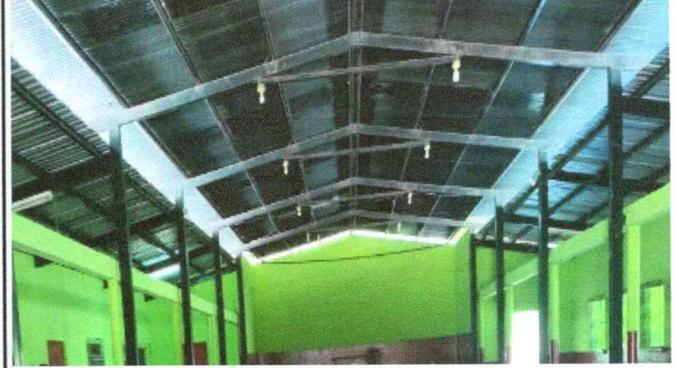
Foto 2: SUSTITUCIÓN DE LÁMINA TROQUELADA TECHO DE LÁMINAS DEL SALON DEL CENTRO OXIDADAS
