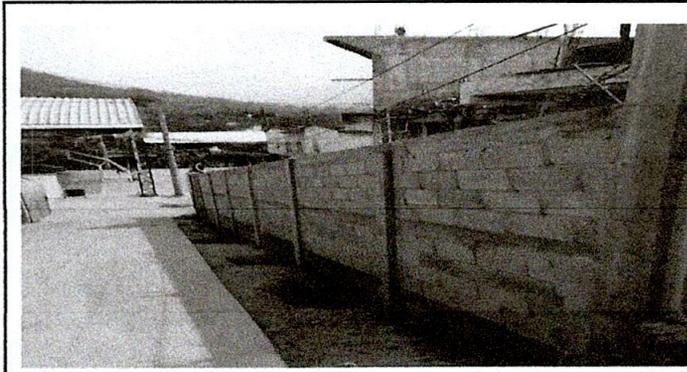
Foto 1: Terminación de 30 metros de muro perimetral de la parte poniente del edificio escolar
