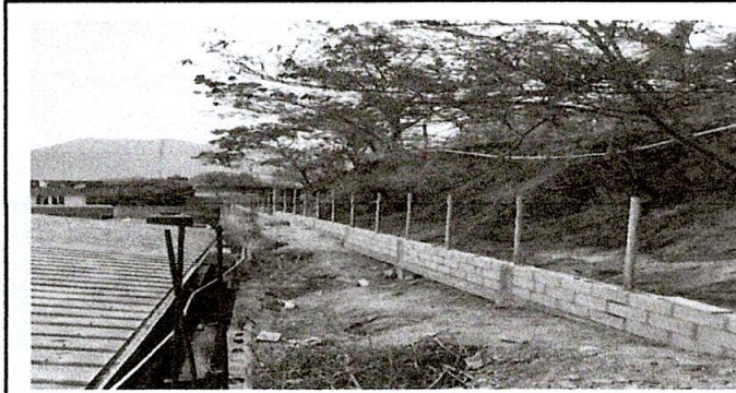
Foto 1: Fundición de columnas con tubos galvanizados para colocación de malla
