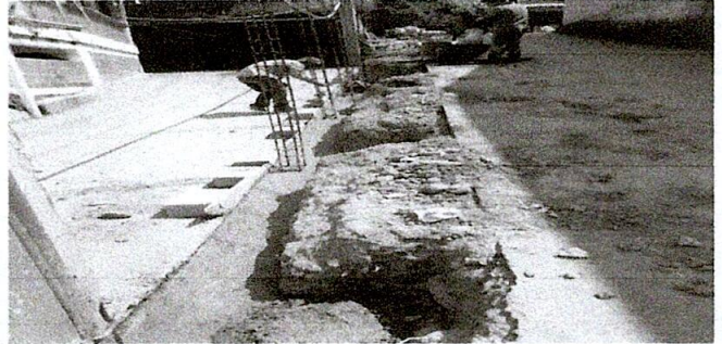
Foto 2: Fundición de la primer solera del muro perimetral
