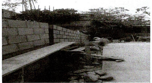
Foto 4: Continuidad de los otros 15 metros de muro perimetral, levantamiento de pared.
