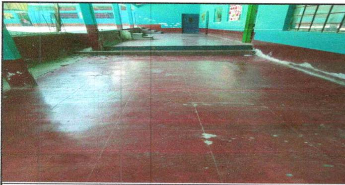
Foto 5: Sustitución de piso de cemento liquido por piso cerámico
