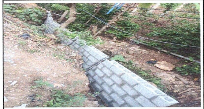
Foto 4: Muro en el arroyo
