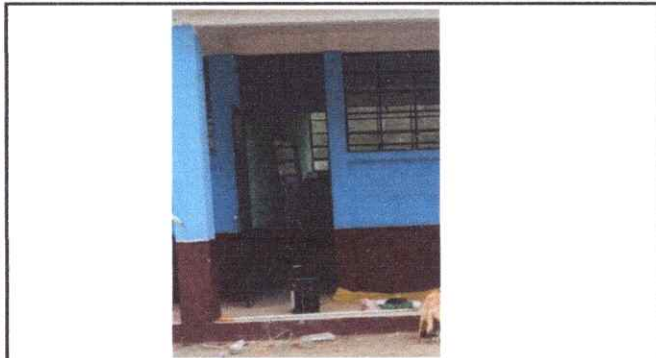
Foto 3: Mantenimiento de puertas
