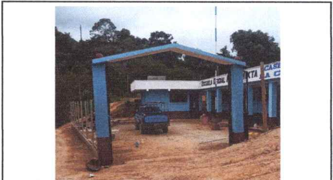
Foto 2: Sustitucion de porton de madera por metal
