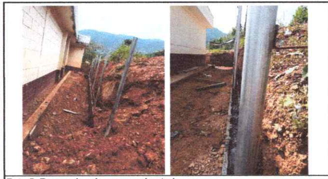
Foto 5: Reparacion de muro perimetral
