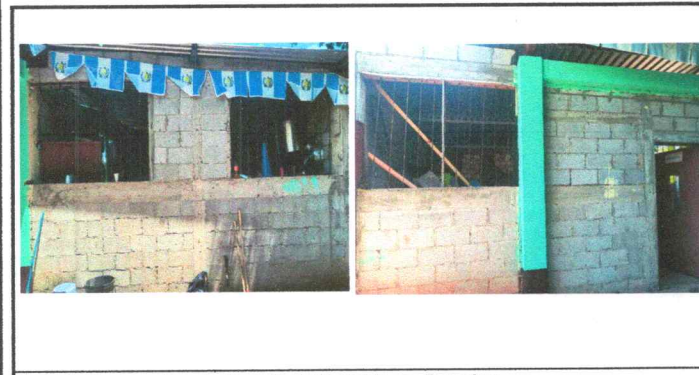
Foto 5: Reparación de Repello Y Cernido de Paredes
