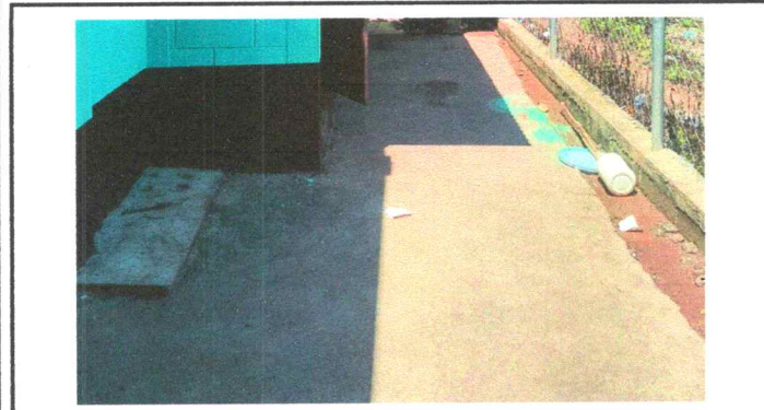
Foto 3: Reparación de piso de granito
