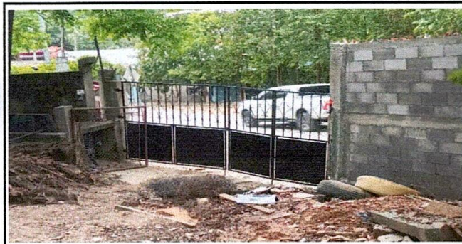
Foto 5: cambio de porton
