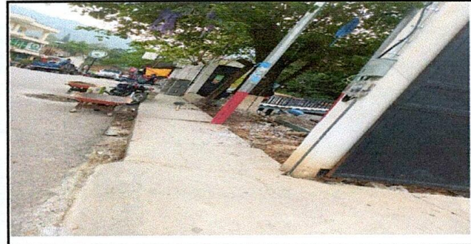
Foto 6: Muro en contruccion
