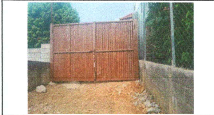
Foto 4: Mantenimiento a portones de metal
