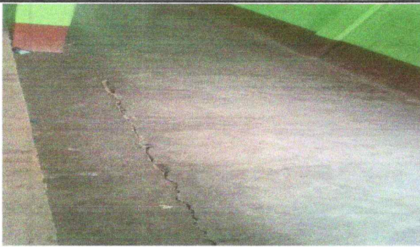
Foto 5: Sustitución de piso de torta de concreto
