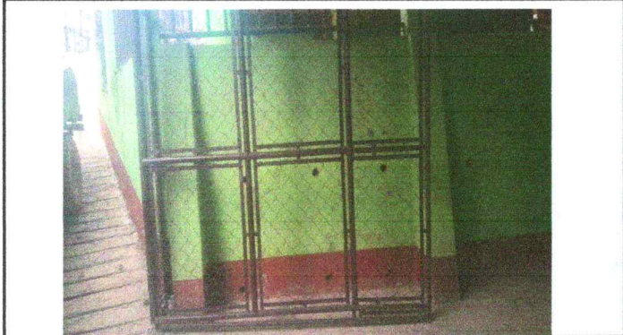
Foto1: Mantenimiento de portones de metal
