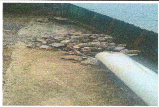
Foto 4: Sustitución de piso de torta de concreto
