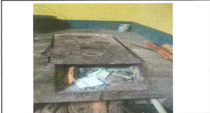
Foto 3: Sustitución de plancha de metal tres hornillas
