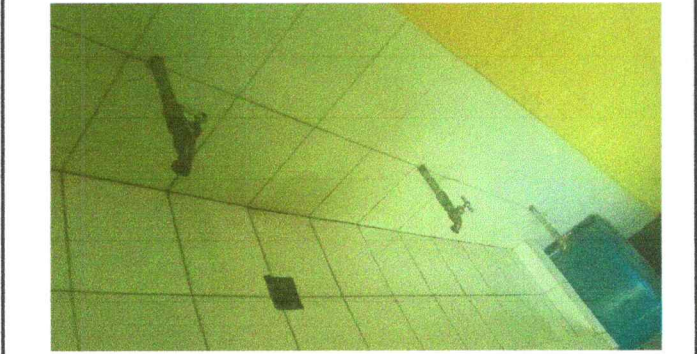
Foto1: Sustrucción de llave de chorros
