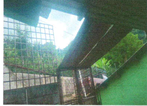
Foto 2: Sustitución de lámina por lámina troquelada
