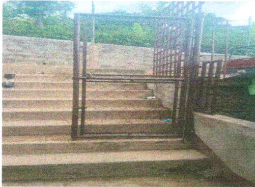
Foto 1: Mantenimientos de portones de metal
