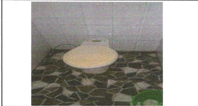
Foto 2: Sustitución de inodoro
