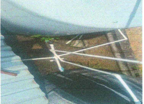
Foto 2: Sustrucción de depósito de agua 1700 Lt
