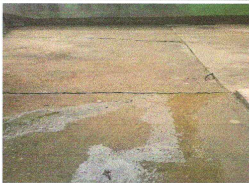
Foto 3: Sustitución de piso de torta de concreto
