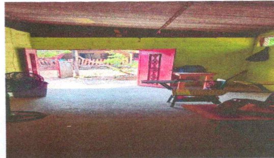
Foto 4: sustitución de portón
