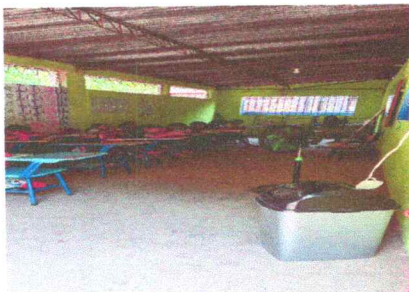
Foto 5: Colocación de piso en aulas
