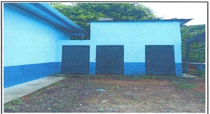
Foto 4: Sustitución de tasas de baño
