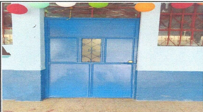
foto 3: sustitución de pintura y chapas
