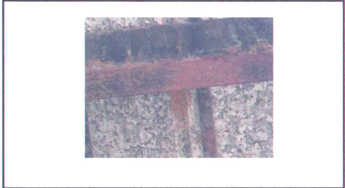
Foto 2: Sustrucción de estructura de soporte de metal
