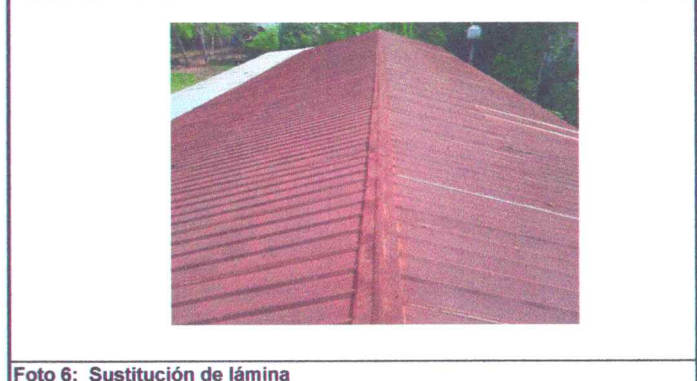
Foto 6: Sustrucción de lámina
