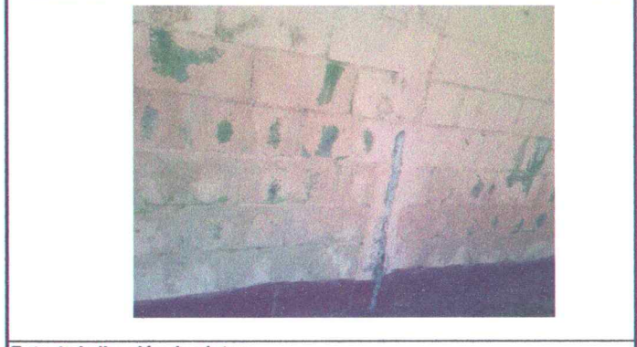
Foto 4: Aplicación de pintura
