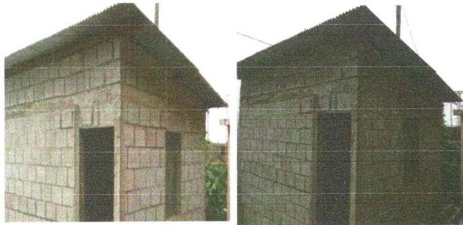
Foto1: Cubierta de lámina
