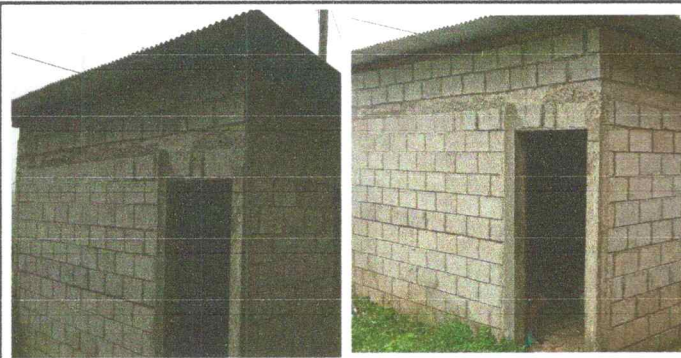
Foto 9: Repello en paredes
