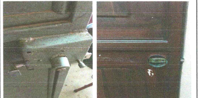
Foto 4: Sustitución de Chapas
