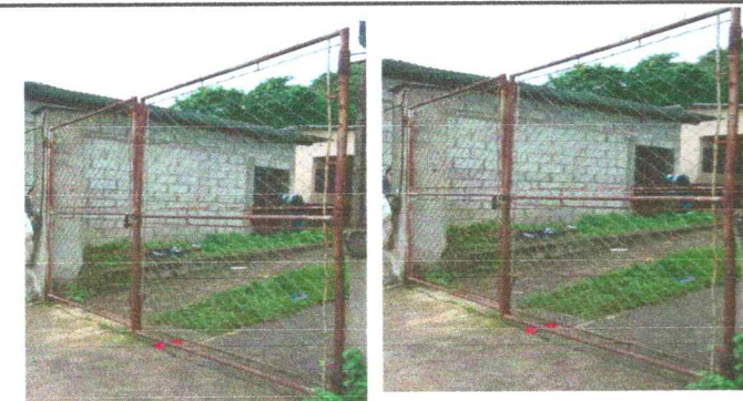
Foto 5: Sustitución de Porton
