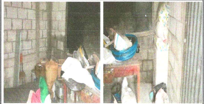
Foto 8: Reparación de cocina
