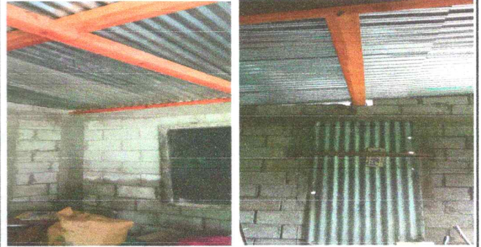
Foto 2: Estructura de techo
