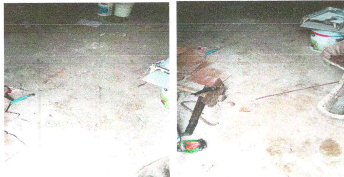
Foto 3: Piso, torta de cemento
