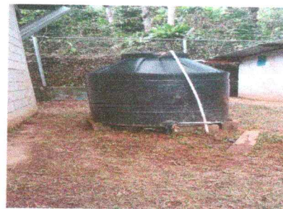
Foto 6: Sustitución de tinaco
