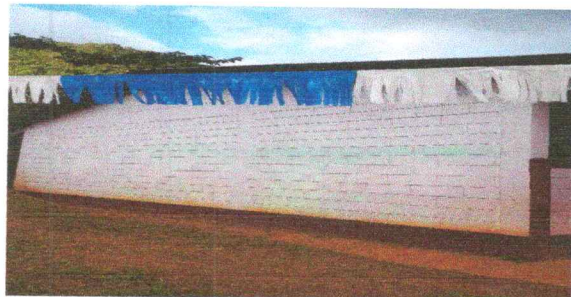
Foto 5: Aplicación de pintura
