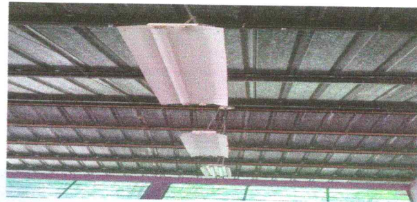
Foto 4: Reparación de sistema eléctrico y sustitución de focos
