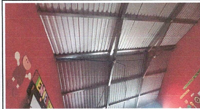
Foto 3: Estructura de techo
