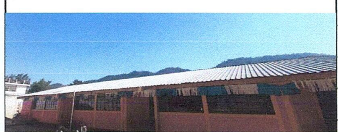
Foto 4: Cubierta de lamina
