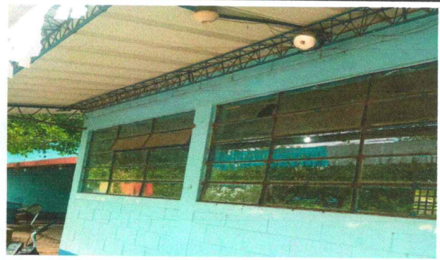
Foto 4: Mejoramiento de balcones
