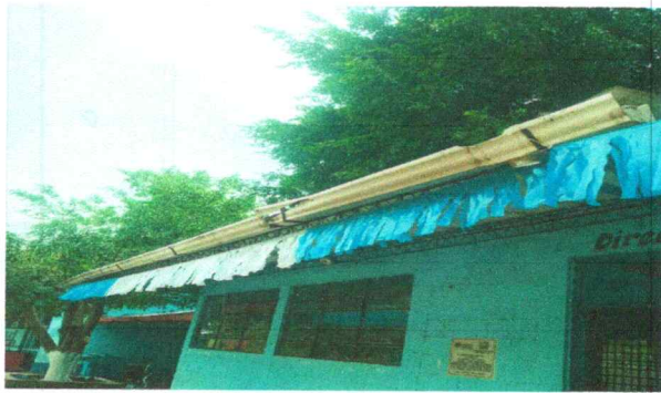
Foto 3: Sustitución de Canales
