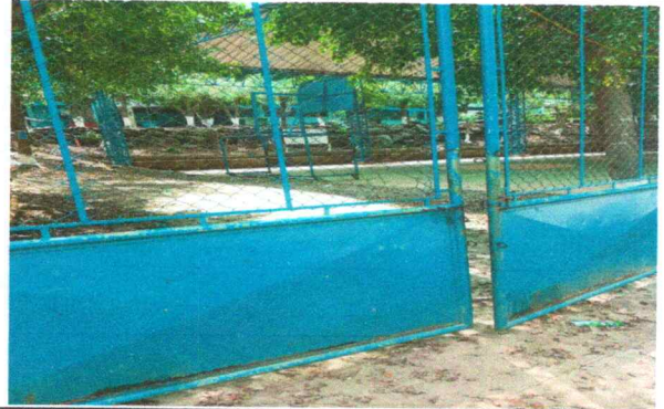
Foto 2: Sustitución de de portón
