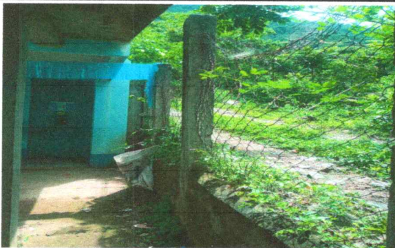
Foto 5: Reparación de muro perimetral
