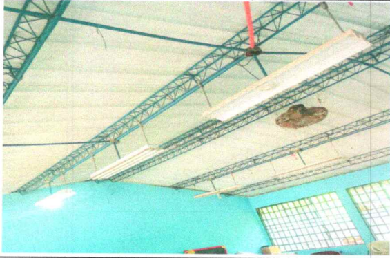
Foto1: Sustitución de lámparas
