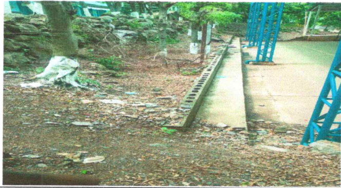
Foto 7 Reparación de muro de contención
