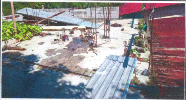
Foto 4: Reparación de muro de Block
