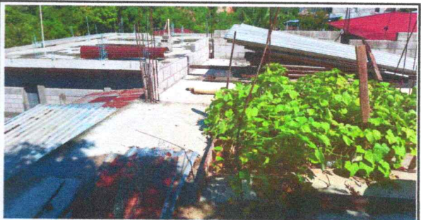
Foto 6: Reparación de muro de block
