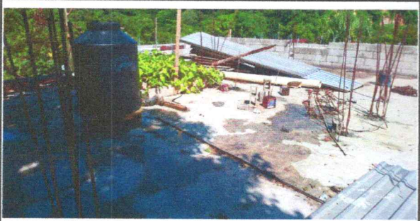
Foto 5: Reparación de muro de Block
