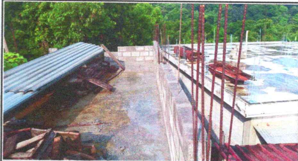
Foto 2: Reparación de muro de block
