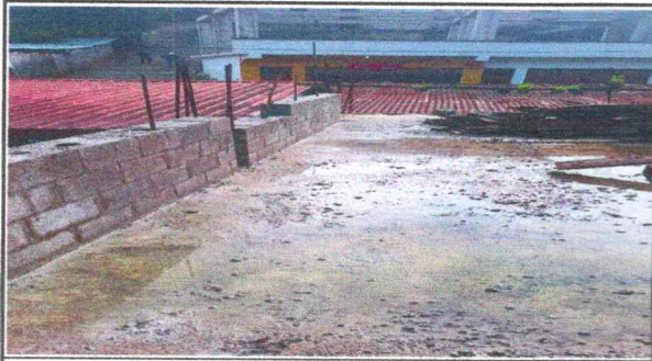
Foto 3: Reparación de muro de Block
