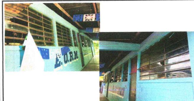
**Foto 5: Sustitución de ventanas de metal a material PVC mas vidrio, 19 mts. Cuadrados.**
