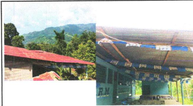
**Foto 3: Sustitución de estructura de soporte de madera, por metal, 168 mts. Cuadrados.**
