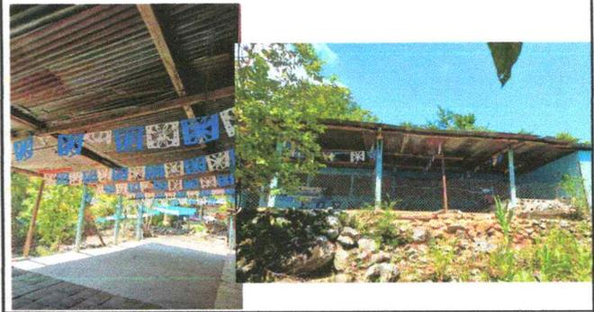
**Foto 2: Sustitución de lámina, por lámina troquelada aluzinc calibre 26-168 mts. Cuadrados.**
