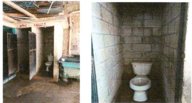
Foto 8: Reparación de azulejo en baño.
