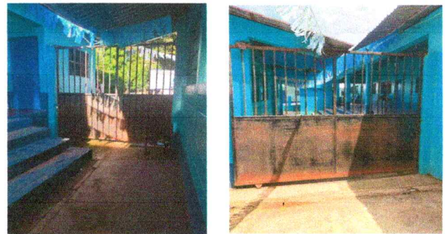
Foto 10: Mantenimiento a portón de metal
