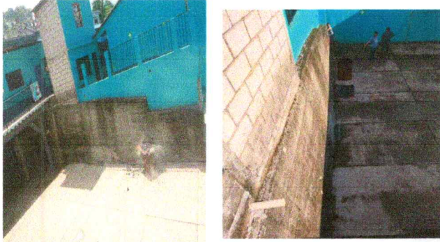
Foto7: Reparación muro de contención
