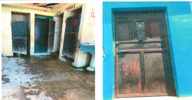
Foto11: Mantenimiento a estructura de puertas de metal
